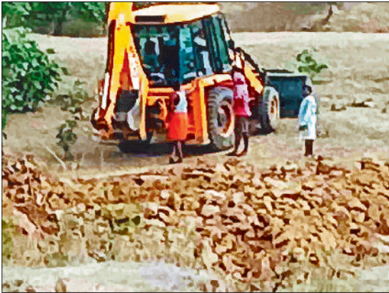
निर्माण में लगे जेसीबी ।
